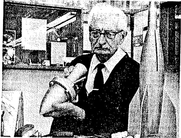
Die Kegeldüse, die Hermann Oberth in Händen hält, wurde von ihm 1929 erfunden und ist der Vorläufer aller Raketenmotoren. Heute ist sie Bestandteil der Ausstellung im Hermann-Oberth-Museum in Feucht. Archivfoto: dpa
