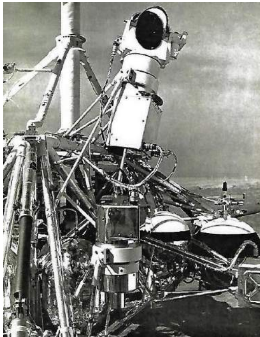
Das TV-Kamera-System von Surveyor 1
